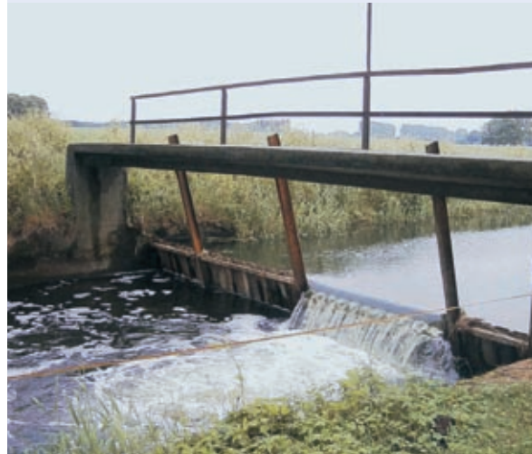
Abb. 3.29: Kulturwehr, Bauweise ähnelt einem Nadelwehr
