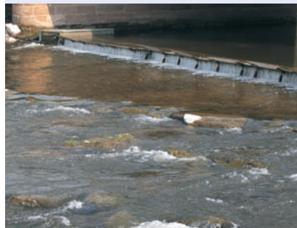
Abb. 10.63: Funktionskontrolle an einer Fischrampe, mit Sperre und Kastenreuse (links)
