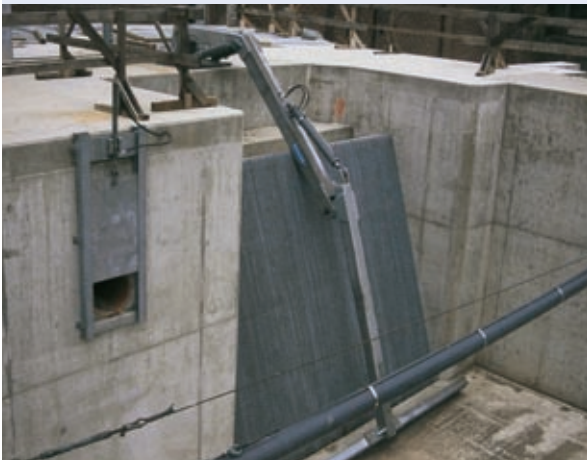
Abb. 4.25: Horizontal-Rechenreiniger
