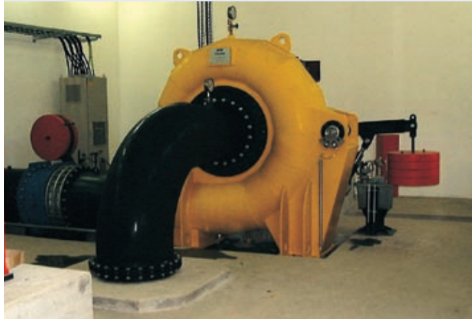
Abb. 4.9: Francis-Spiralturbine für mittlere und große Fallhöhen
