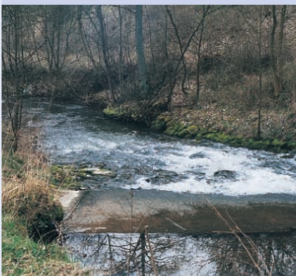
Abb. 13.7: Ausleitungsstrecke unmittelbar unterhalb des Wehrs
