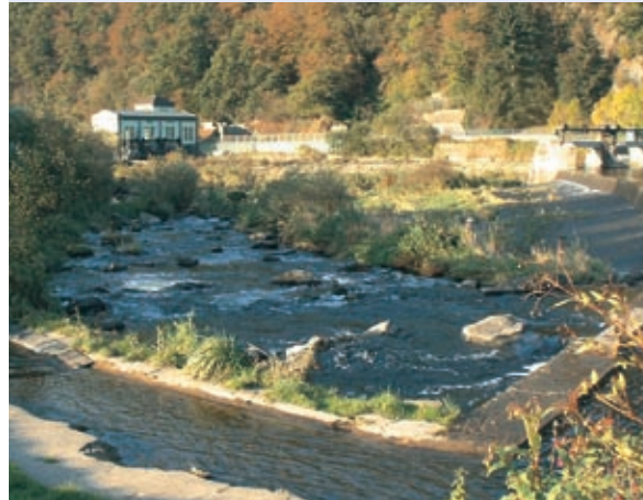
Abb. 12.38: WKA Unkelmühle. Im Vordergrund die Fischrampe, rechts das Wehr
