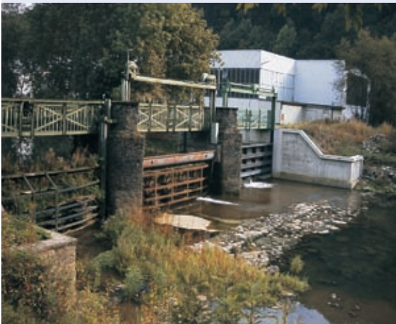
Abb. 3.22: Stahlschützen, in der Mitte mit aufgesetzter Klappe
