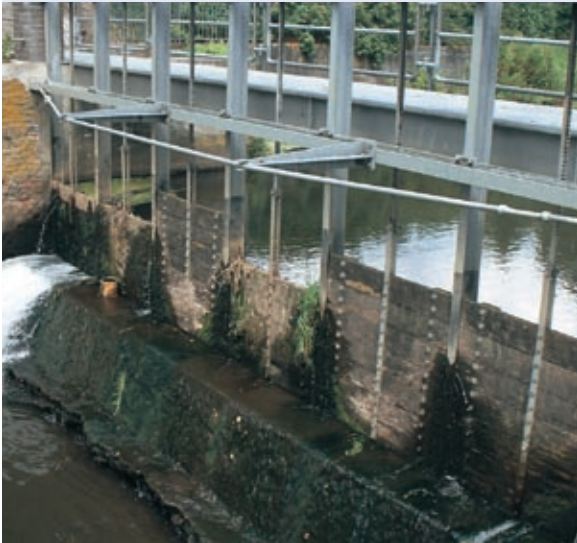
Abb. 3.21: Mehrfeldriges Schützenwehr mit Holztafeln
