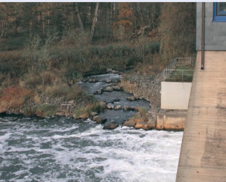
Abb. 10.33: Fischaufstiegsanlage am Wehr Beckinghausen (Lippe): Anordnung des Einstiegs am Ende des turbulenten Bereichs
