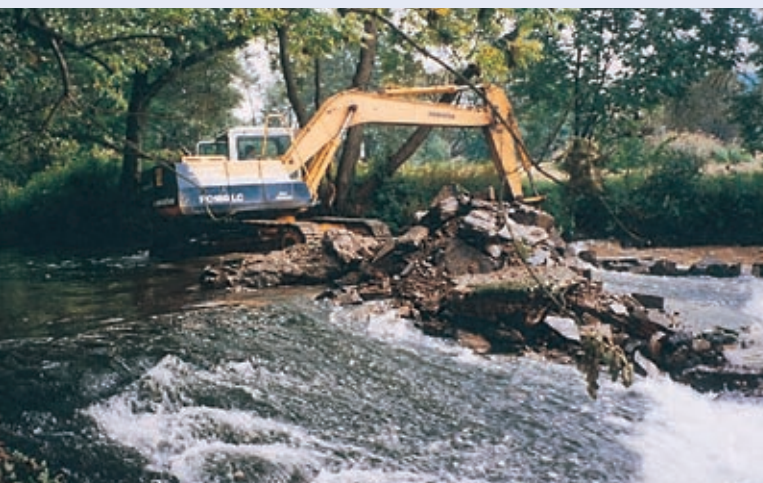
Abb. 10.2: Rückbau eines Stauwehres im Brölunterlauf bei Hennef Müschmühle
