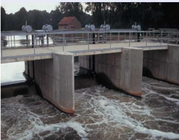
Abb. 3.23: Unter- und überströmte Schützenanlage als Kulturwehr
