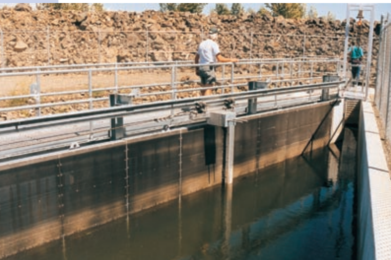
Abb. 12.28: Schräg in einem Gerinne angeordnete Barriere mit seitlicher Abspülung des Rechenguts. Der Abspülkanal kann als Bypass dienen. Voraussetzung ist auch hier, dass die gesamte Anordnung auf das Verhalten der Zielarten ausgelegt ist.
