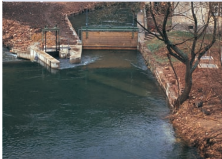
Abb. 4.22: Staubereich mit Wehr, Spülschütz und Einlaufbauwerk
