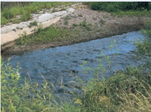
Abb. 7.17: In kleinen Stauräumen tritt eine nicht vollständige Verlandung ein, die teilweise durch Hochwasser gespült wird. Im Bild ist die Verlandung vor dem Wehr bei abgesenktem Stau sichtbar.
