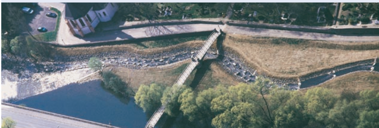
Abb. 10.1: Umgehungsgerinne Hadamar (Hessen) mit gut auffindbarem Einstieg am schräg im Gewässer angeordneten Wehr
