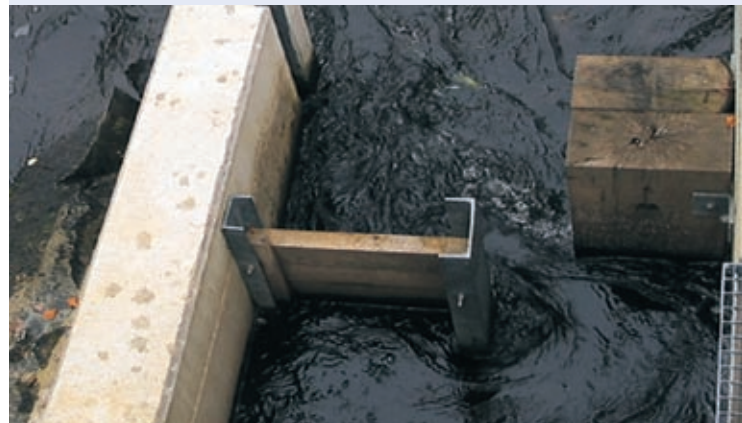
Abb. 10.8: Vertical-Slot-Pass mit niedriger spezifischer Leistung
