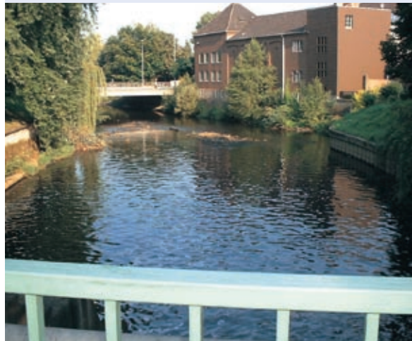
Abb. 2.16: Befestigte Ufer verhindern eine Veränderung des Gewässerlaufs und unterbinden den Kontakt zur Aue
