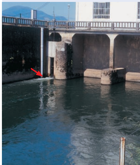
Abb. 10.24: Unterwasseransicht des französischen Wasserkraftwerks Halsôu. Rechtsufrig ist der Einstieg in den Fischpass und die Leitströmung zu erkennen (Pfeil).
