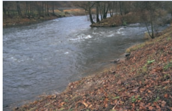
Abb. 10.27: Mündung eines Unterwasserkanals (rechts) ohne eindeutig wirkende Leitströmung
