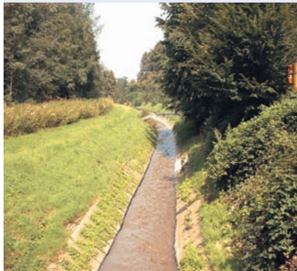
Abb. 2.17: Die Emscher wurde als Abwasserkanal ausgebaut
