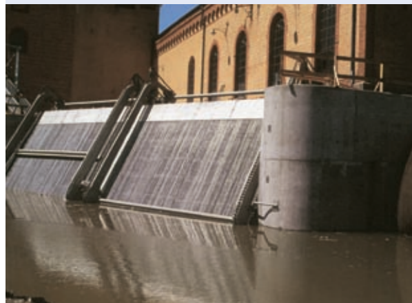
Abb. 4.26: Rechenanlage mit Kettenreiniger
