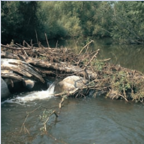
Abb. 10.64: Verklausung einer Steinschwelle, wodurch die Wasserspiegeldifferenz ansteigt und der Aufstiegsquerschnitt verengt wird
