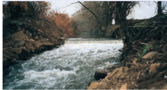
Abb. 10.14: Künstlicher Sohlenabsturz als Fischbarriere in einem Unterwasserkanal
