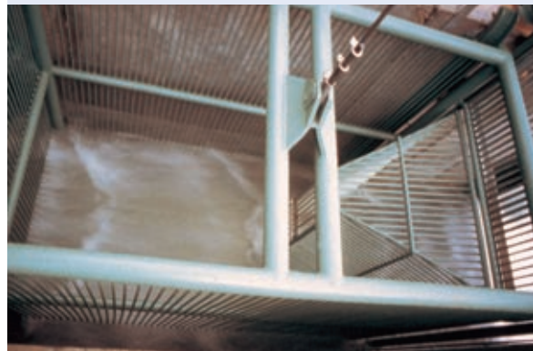
Abb. 10.53: Fang- und Transportkorb eines Fischeaufzugs
