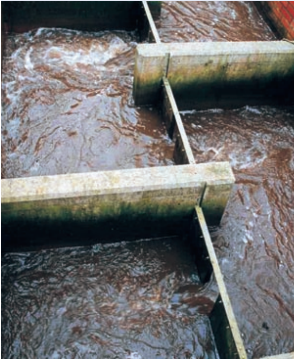
Abb. 10.48: Vertical-Slot-Pass in kompakter Ausführung mit versetzten Becken (Heiligenrode, Brandenburg)
