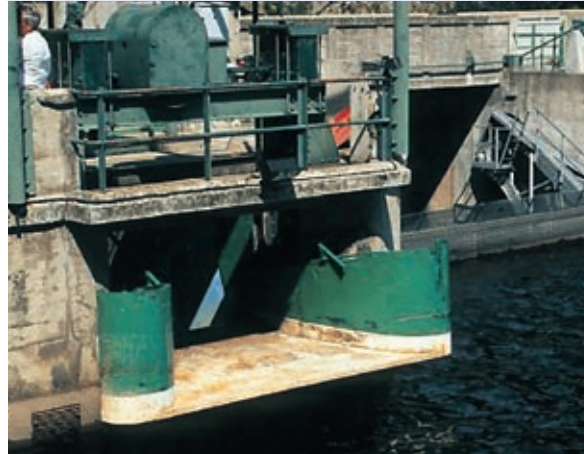
Abb. 12.20: Bypass für pazifische Lachssmolts im spitzen Winkel eines Fischschutz-Rechens (USA)
