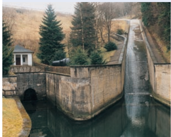
Abb. 7.20: Am Grundablass von Talsperren (links) wird kaltes Tiefenwasser entnommen (Bevertalsperre)
