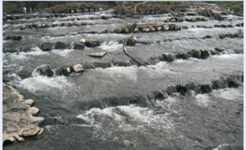
Abb. 10.67: Sehr flache Rampe mit überströmten Schwellen und geringerer Neigung zur Verklausung
