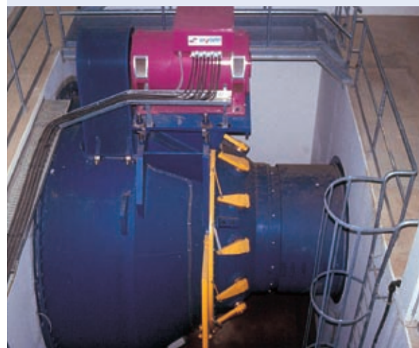
Abb. 4.15: Kaplan-Rohrturbine mit Riementrieb zum aufgesetzten Generator
