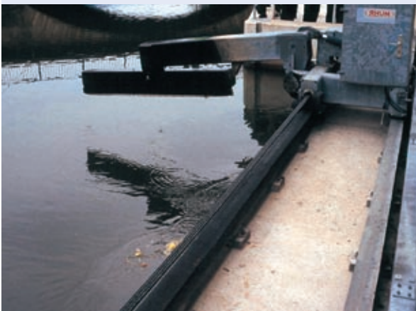
Abb. 4.25: Horizontal-Rechenreiniger
