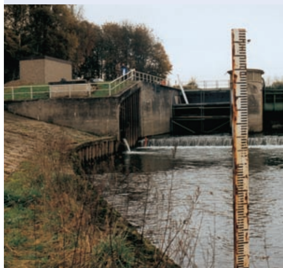
Abb. 13.16: Links: Zusätzliche Wasserkraftanlage zur energetischen Nutzung des Mindestabflusses an der Wehranlage Hengsen/Ruhr. Der Auslauf der Turbine mündet unmittelbar unterhalb der letzten Wehrrschwelle in das Gewässer.
