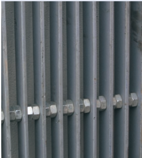
Abb. 12.9: Konventioneller Rechen aus Flachstahl
