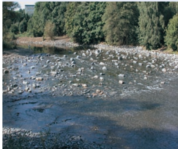
Abb. 10.37: Fischrampe Hüsten/Ruhr bei Niedrigwasserabfluss. Die Störsteine sind nur bei sehr hohem Abfluss hydraulisch wirksam.
