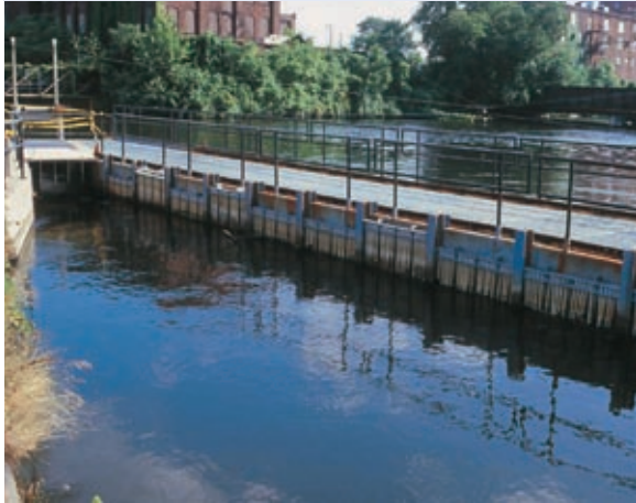
Abb. 12.17: Louver in einem Betriebskanal, links der Bypass für den Abstieg von Lachssmolts
