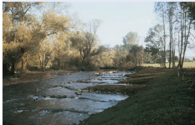
Abb. 10.41: Rampe mit Niedrigabflussrinne am Elbbach (Hessen)
