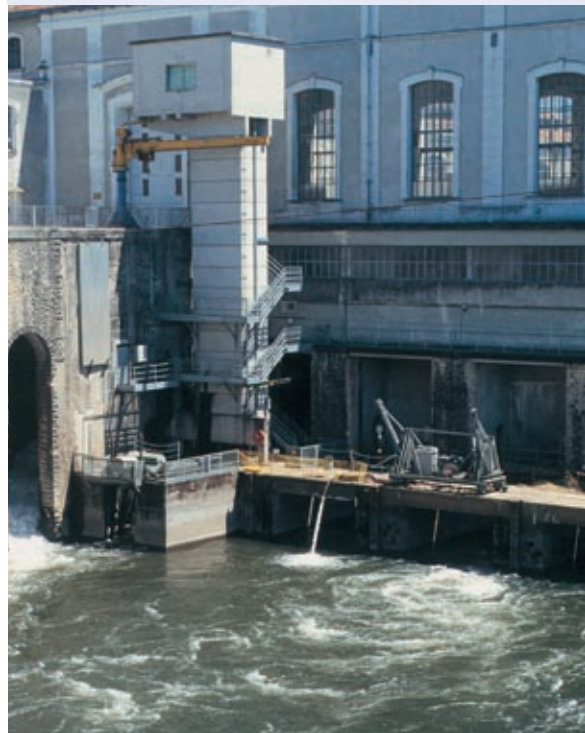
Abb. 10.54: Fischeaufzug am Kraftwerk Tuiliere/Dordogne (Frankreich)
