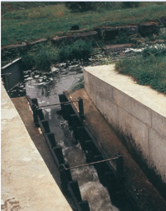
Abb. 10.51: Denil-Pass am Kraftwerk Unkelmühle (Sieg) als Ergänzung zu der naturnahen Fischaufstiegenanlage am Wehr
