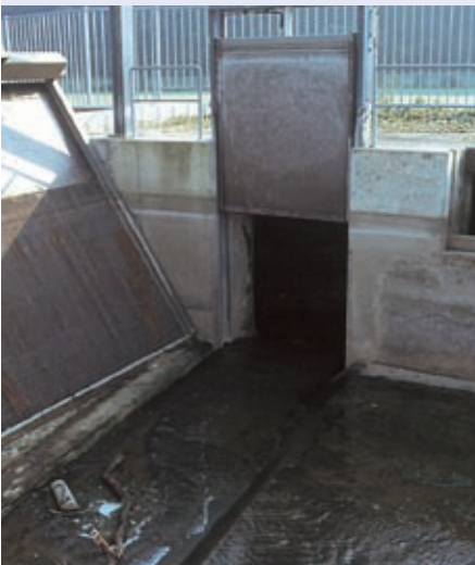
Abb. 4.21: Rechen mit Spülschütz zum Leerschuss
