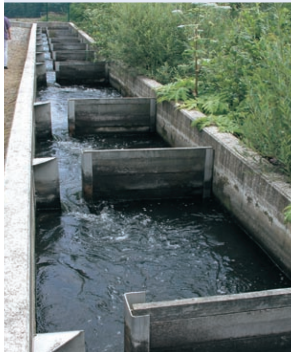
Abb. 10.49: Vertical-Slot-Pass Stiftsmühle/Ruhr, spezifische Leistung p=80 \text{ W/m}^3
