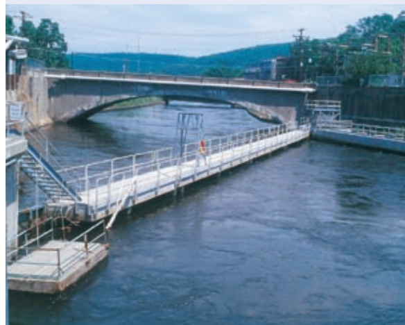
Abb. 12.18: Schräg in einem Betriebskanal angeordnete Tauchwand zur Ableitung von Lachssmolts in einen Bypass (links), Blick gegen die Fließrichtung
