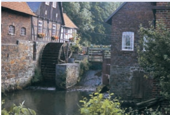
Abb. 3.4: Bereits früh wurden Gewässer zur Nutzung der Wasserkraft aufgestaut
