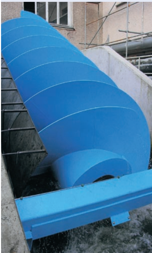
Abb. 4.7: Wasserkraftschnecke
