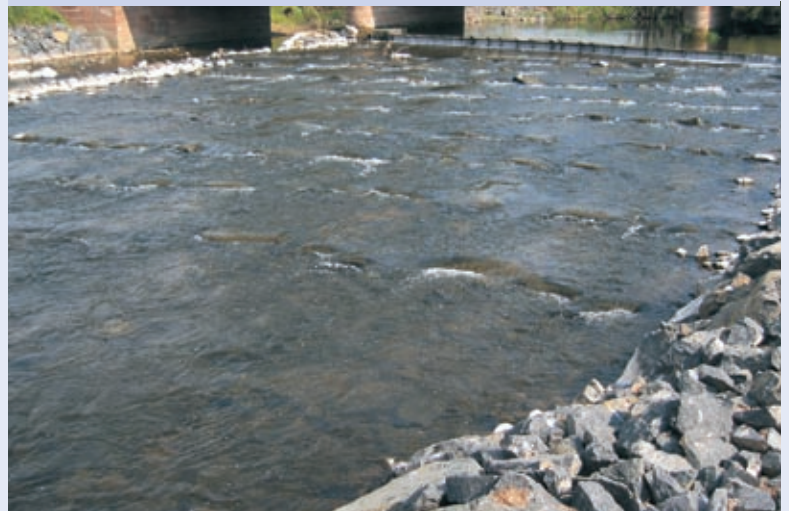
Abb. 10.67: Sehr flache Rampe mit überströmten Schwellen und geringerer Neigung zur Verklausung
