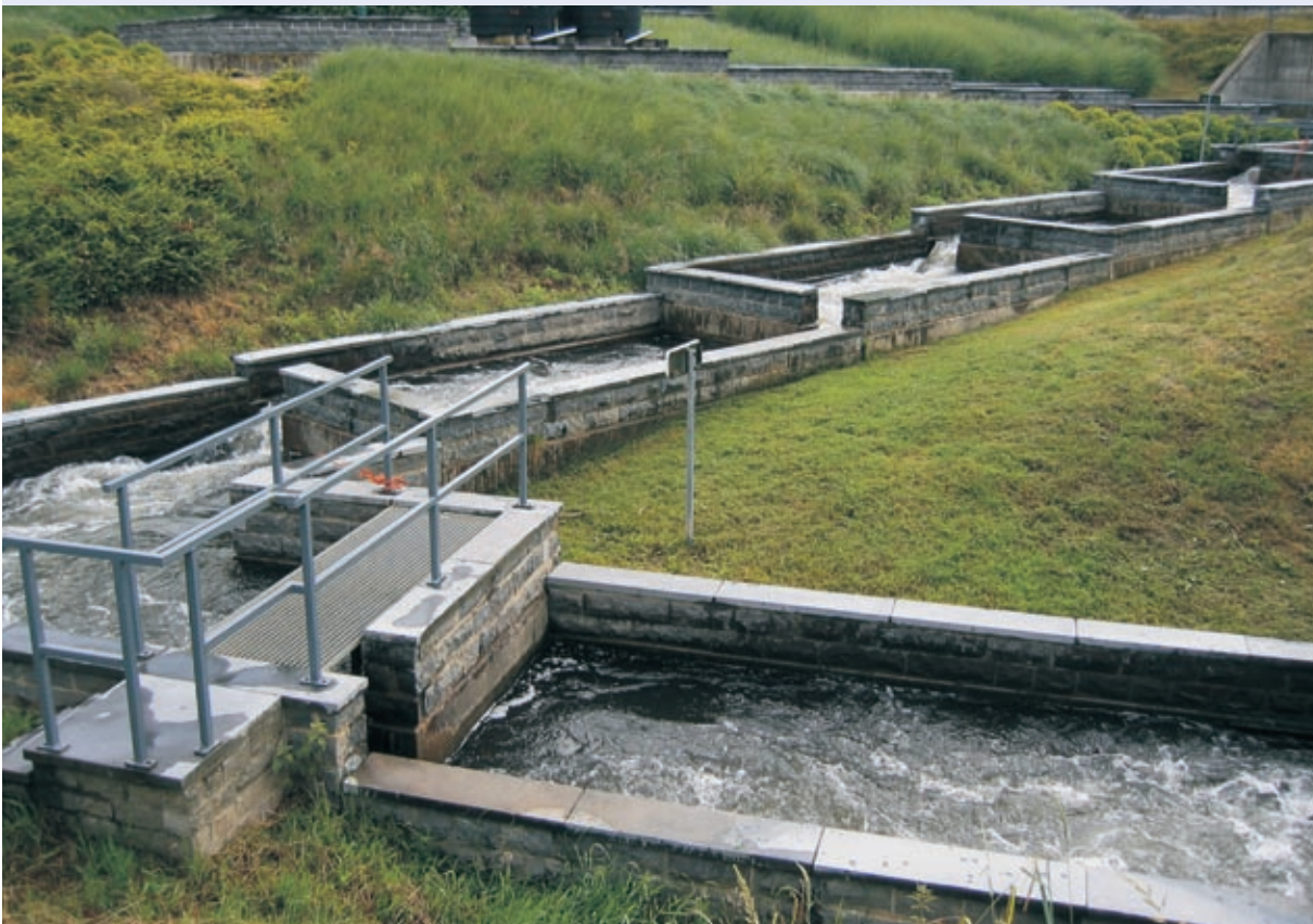
Abb. 10.50: Vertical-Slot-Pass am Kraftwerk Lixhe/Maas (Belgien). Abfluss im Pass ca. 2 \text{ m}^3/\text{s} . Im untersten Becken mündet ein Bypass zur Verstärkung der Leitströmung mit ca. 5 \text{ m}^3/\text{s}
