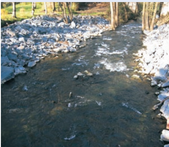
Abb. 10.40: Rampe nach weitgehendem Rückbau eines Wehrs in der Forellenregion
