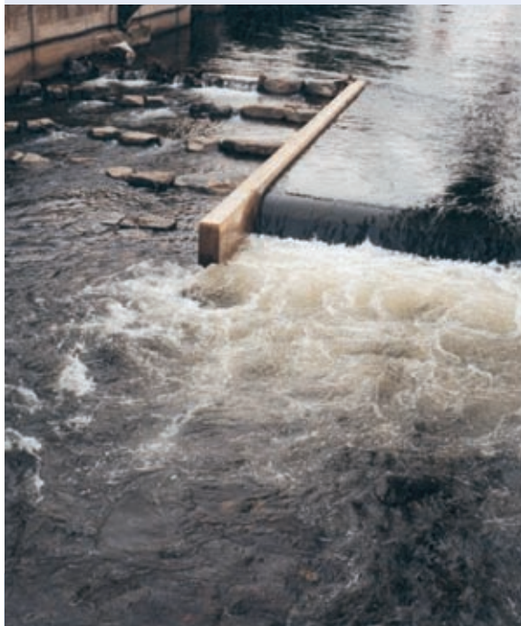
Abb. 10.32: Oben: Fischaufstiegsanlage Wuppertal-Barmen mit Einstieg unmittelbar neben dem Tosbereich der Wehrklappe. Grafik unten: In das Oberwasser verschobene Anordnung des Fischaufstiegs, wodurch der Einstieg in der Wehrachse platziert werden kann. Je breiter der Fischaufstieg und je höher sein Abfluss ist, desto besser ist die Auffindbarkeit.
