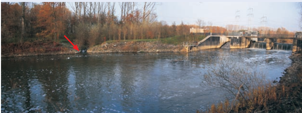
Abb. 10.23: WKA Hamm Uentrop mit schlecht auffindbarem Einstieg in das Umgehungsgerinne (zu weit unterhalb der WKA)
