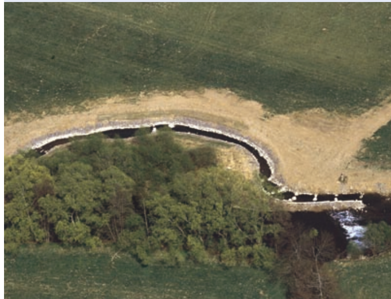
Abb. 10.34: Umgehungsgerinne am Elbbach (Hessen). Der Einstieg befindet sich unmittelbar neben dem Wehr
