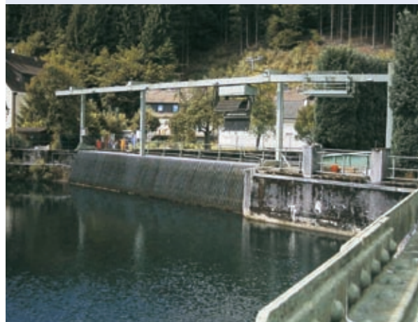
Abb. 4.26: Rechenanlage mit Kettenreiniger
