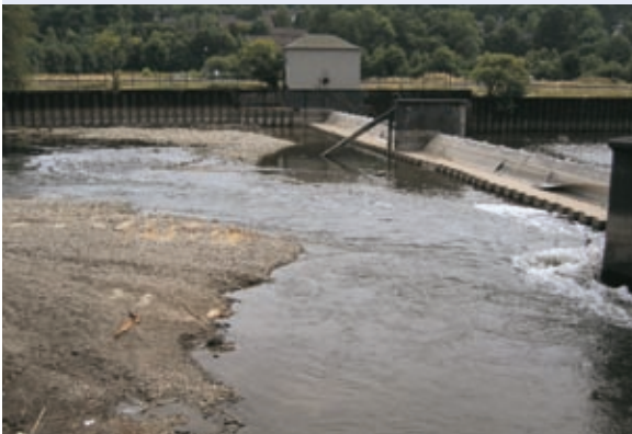
Abb. 7.17: In kleinen Stauräumen tritt eine nicht vollständige Verlandung ein, die teilweise durch Hochwasser gespült wird. Im Bild ist die Verlandung vor dem Wehr bei abgesenktem Stau sichtbar.
