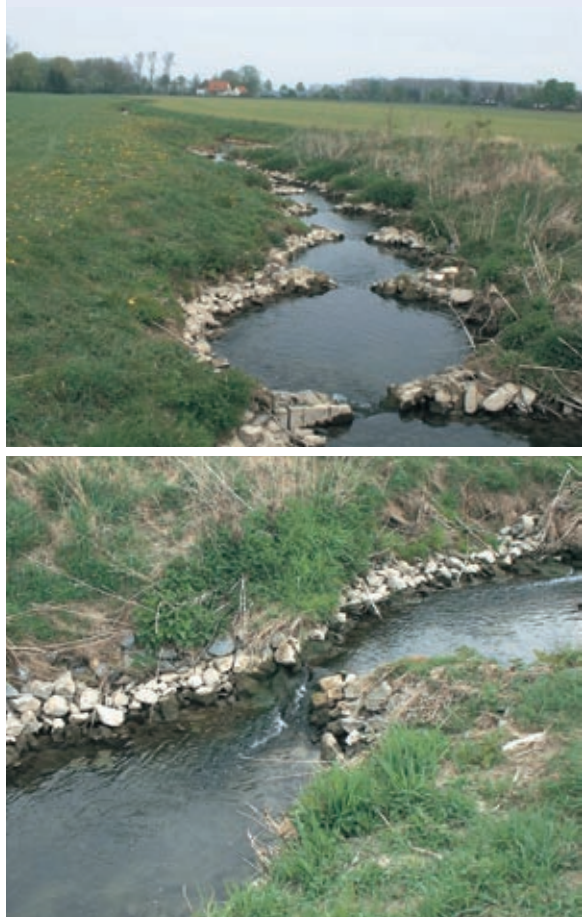
Abb. 10.42: Tümpelpass mit sehr geringem Durchfluss. Die Funktionsfähigkeit hängt von den Abmessungen der durchströmten Öffnung zwischen den Becken ab. Die Passierbarkeit der unten gezeigten Engstelle ist fraglich.
