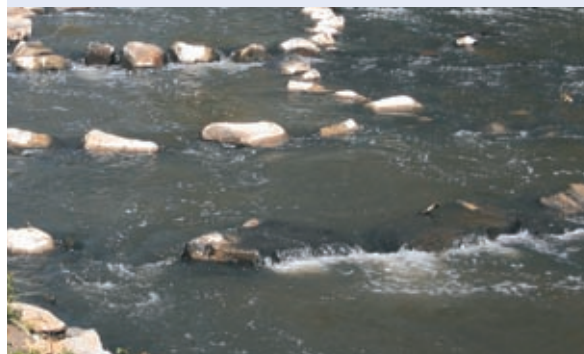
Abb. 10.4: Fischaufstiegsanlage mit niedriger spezifischer Leistung
