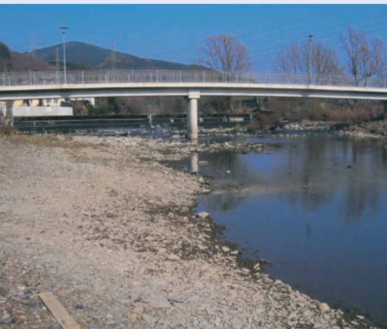
Abb. 7.3: Ausleitungsstrecke in der Lenne
