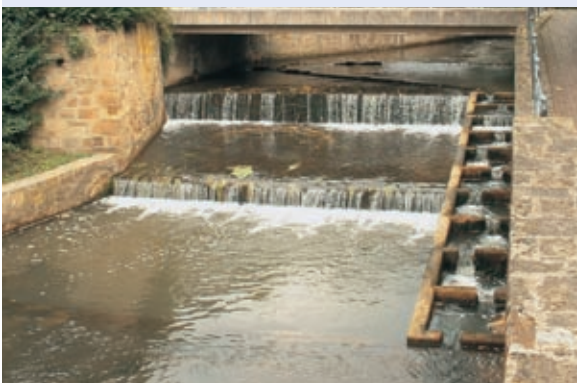
Abb. 10.22: Nicht auffindbarer Fischpass: unzureichende Leitströmung, Einstieg zu weit unterhalb des Wehrs
